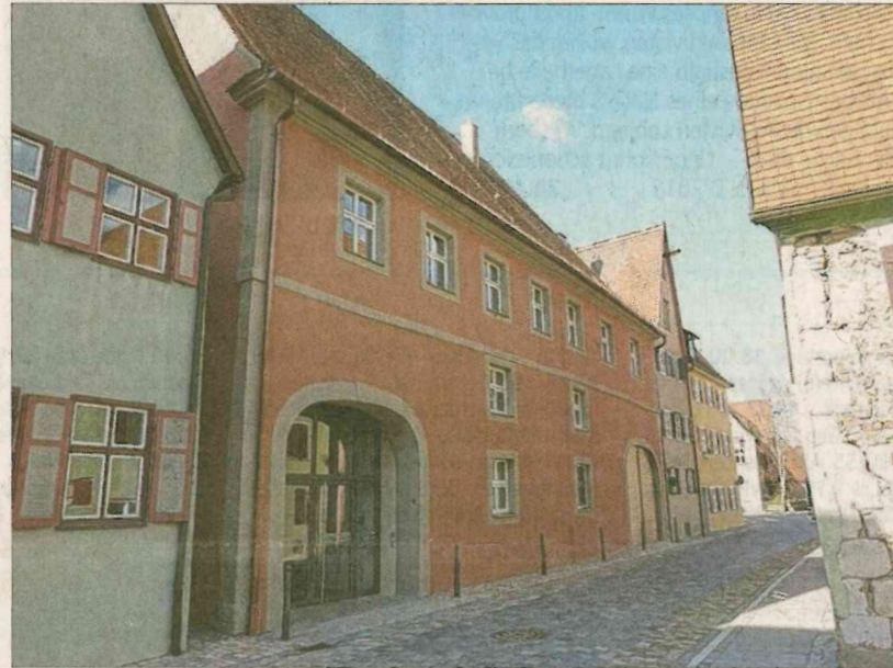
Außen historisch, innen auf dem neuesten Stand der Technik: Das „Graser-Haus“ ist saniert und beherbergt Berufsschüler. Foto: Heinz Meyer
